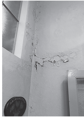
図1 塗装の剝落
