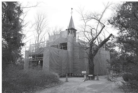
図5 工事のため足場が組まれ、メッシュシートで覆われた碌山館
